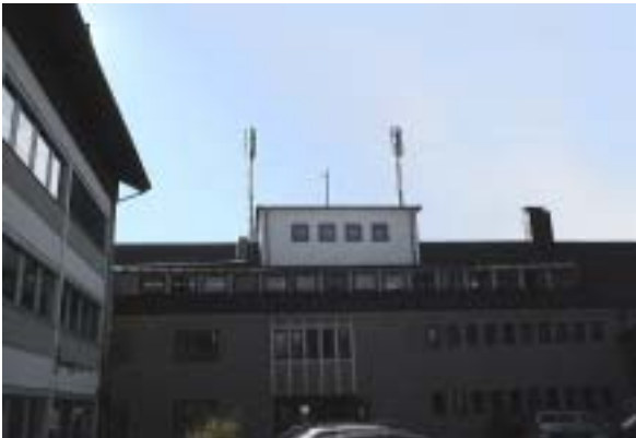
D-Netz Mobilfunkmast auf einem Betriebsgebäude
